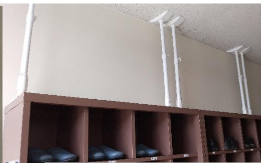
転倒防止の突っ張り棒の設置
