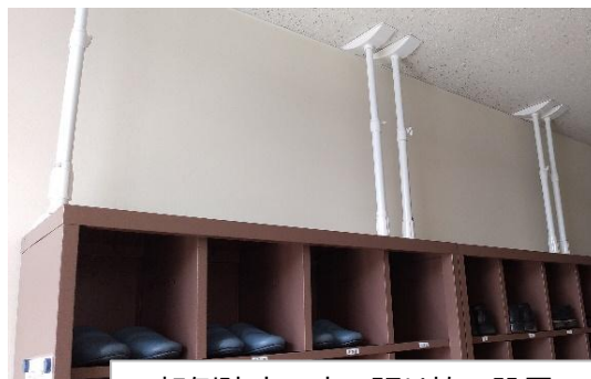
転倒防止の突っ張り棒の設置
